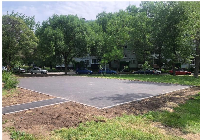
Фото объекта «В работе»
